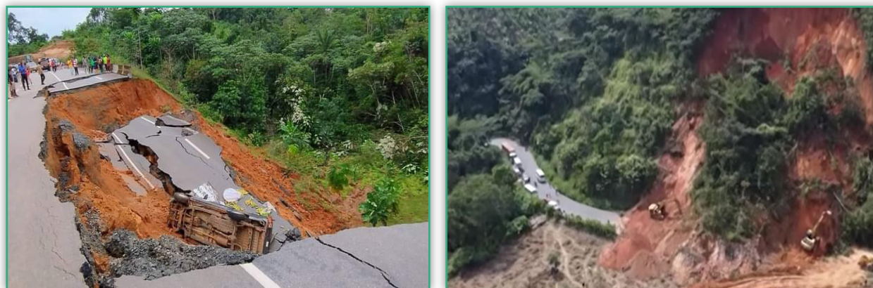
Figure 12 : phénomènes climatiques extrêmes et dégradation des infrastructures (affaissement de la route Bonépoupa-yabassi(fig1) et glissement de terrain de la falaise de Dschang(fig2)) source : www.cameroon-concord.com
